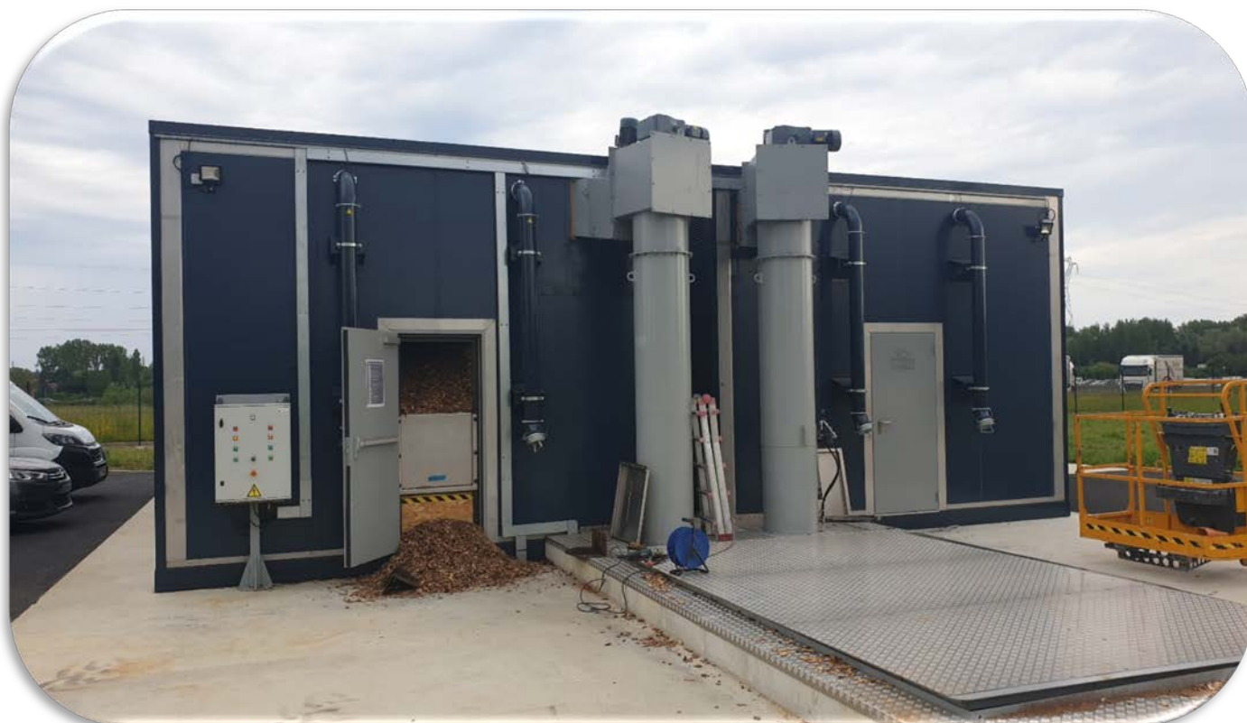
Stora skrapförrådet är nedbyggt i marken.
