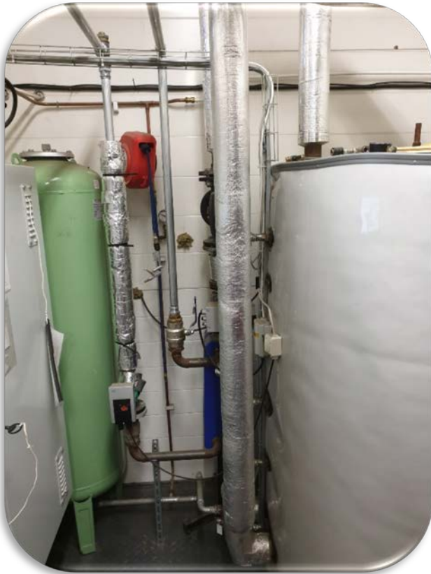
Acktank inbyggd i värmecentralen
