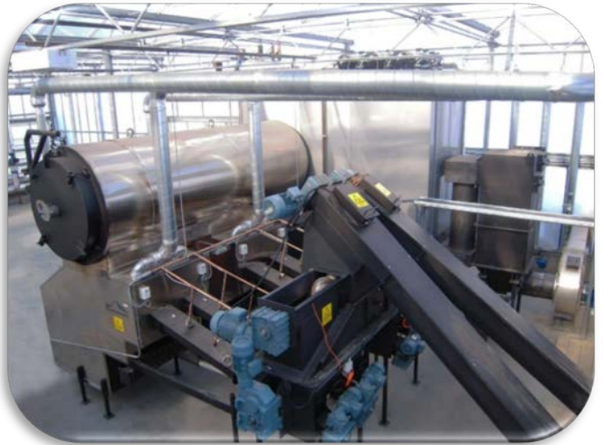
Från förrådet matas materialet till ett mellan-förråd.
