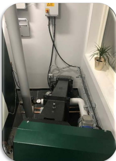
Fjäderförrådet ligger plant i botten och växlas över till den lutande skruven.
