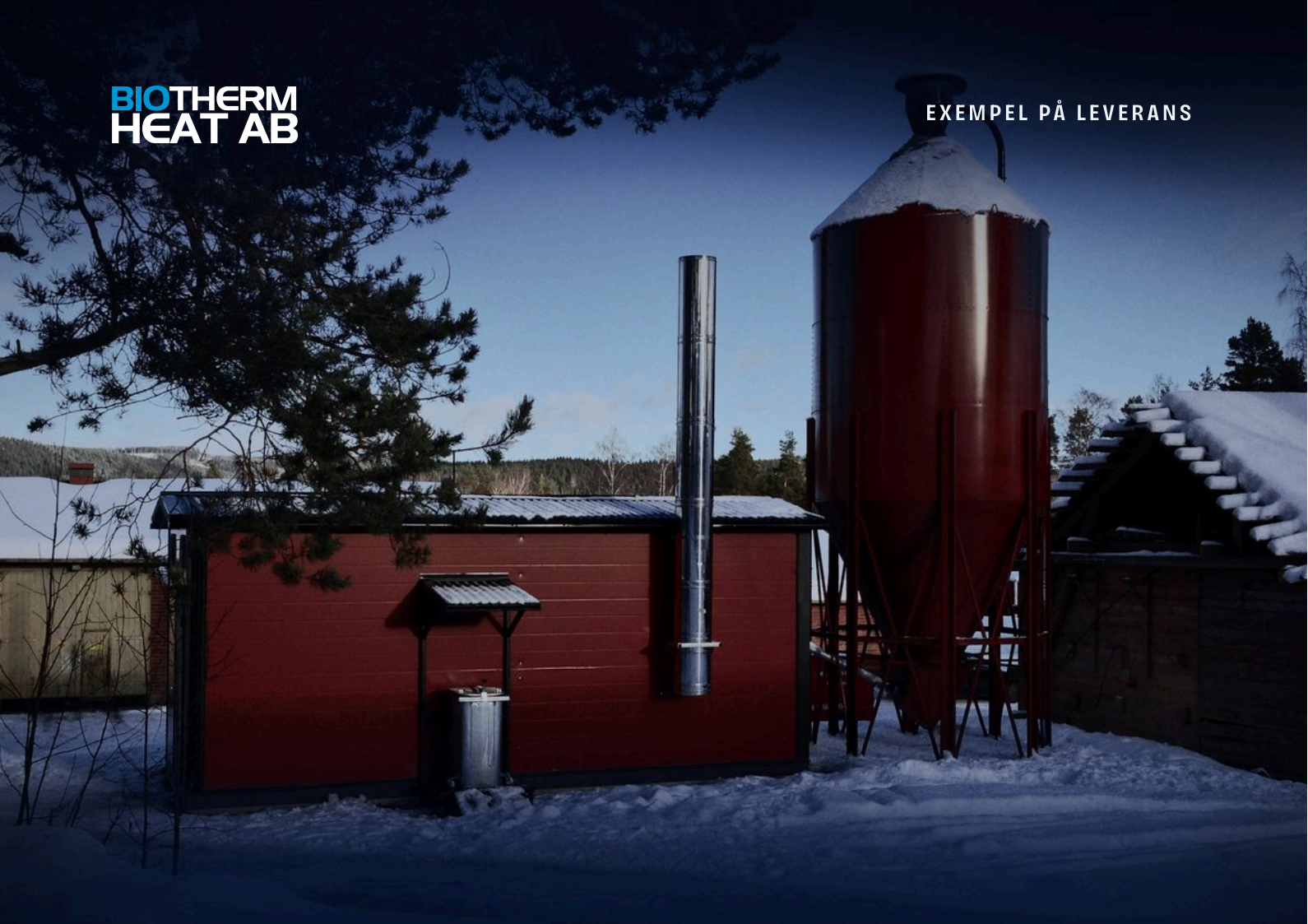
VÄRMECENTRAL MED PELLETSSILO, SKORSTEN OCH ASKBEHÅLLARE
